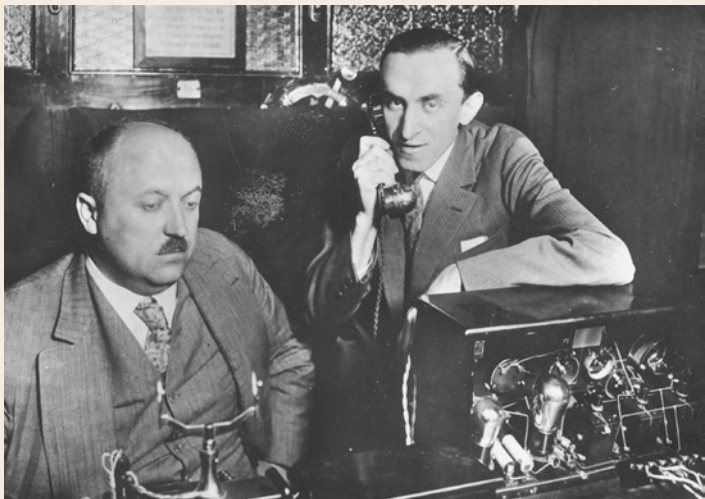
Eksperymenty z telekomunikacją bezprzewodową na kolejach austriackich. Wnętrze wagonu kolejowego. Widoczny m.in. inż. Sliskokovic (przy telefonie) ze swoim wynalazkiem. 1926. Zbiory Narodowego Archiwum Cyfrowego, partnera konkursu O! ZNAKI PRACY.
